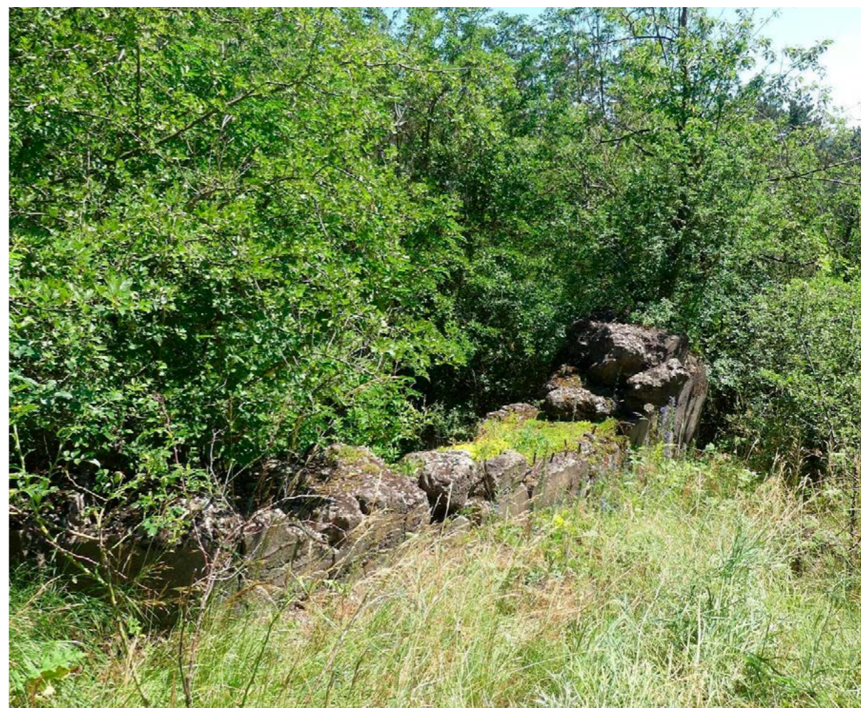
Zarůstající bunkr na jihozápadní stráni – stav před počátkem činnosti
