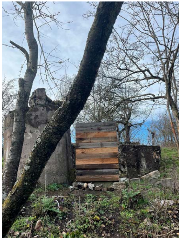
Bunkr na jihozápadní stráni po výřezch, s nainstalovanou budkou pro dudka, 2023
